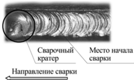
Рис. 8.4. Начало сварки при смене электрода.
